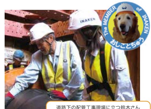
道路下の配管工事現場に立つ鈴木さん 広報担当部長のすずっ君も応援してくれています
